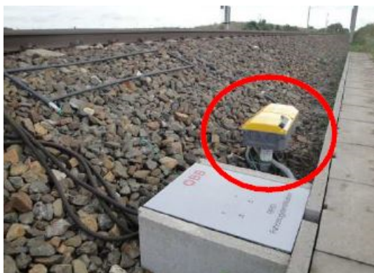
Obr. 2 Příklad umístění čtečky RFID v kolejišti
